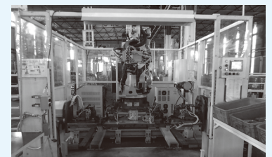
溶接ロボット
