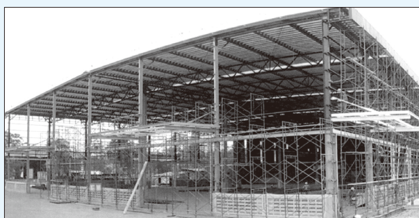
2011年7月11日 工場拡張(建設中)の全景
