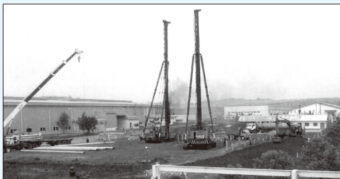
2007年4月16日 杭打ちをやり始めました。
