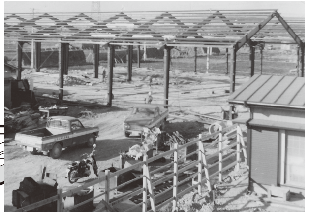
1969年(昭和44年)建設の北工場第1溶接工場
